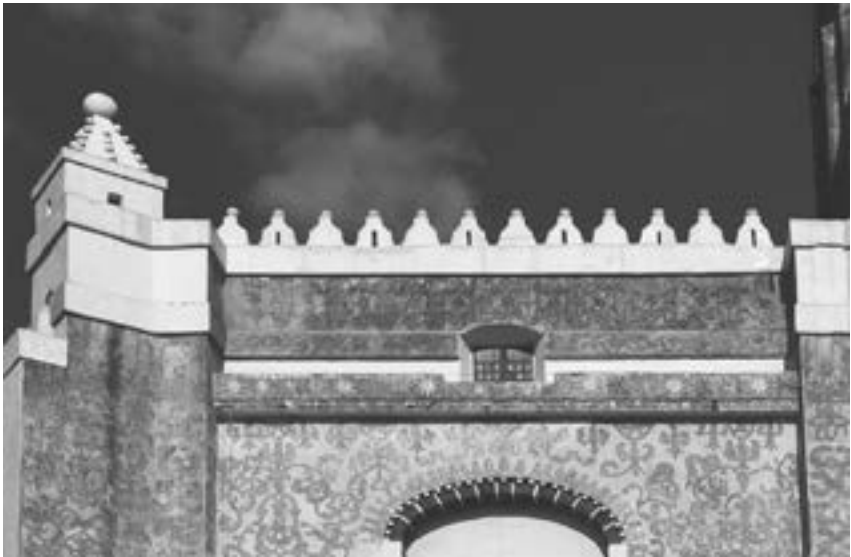
Figura 21. Almenas en la fachada principal del templo del convento de Tepeaca Fuente: fotografía de Adriana Dávila. Archivo propiedad del autor.
