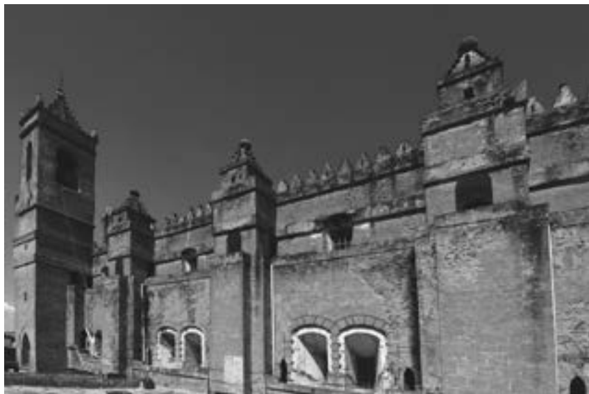
Figura 18. Contrafuertes del lado sur del templo del convento de Tepeaca Fuente: fotografía de Adriana Dávila. Archivo propiedad del autor.
