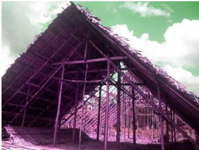
La maloca en construcción
